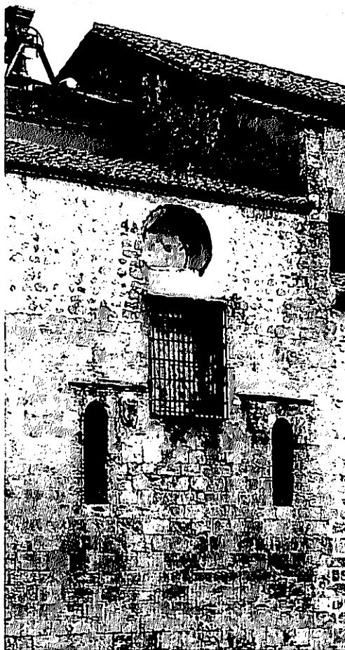
Fachada Sur, exterior capilla Soterraña
